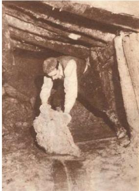
Ces blocs étaient acheminés par les *hercheurs* du fond de la galerie jusqu'au puits. Les *hercheurs* disposaient d'une brouette ou parfois faisaient glisser les « *rukes* » sur des planches humidifiées et les accrochaient au câble du treuil, puis prévenaient les « *trèyeux* » en tirant sur un filin qui agitait une sonnette. Plus tard, on installa dans les galeries des rails et des wagonnets.
