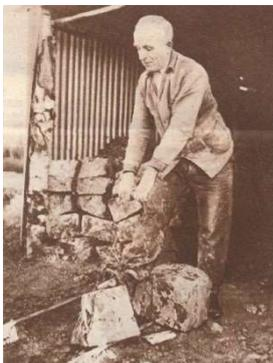
A la surface, à l'aide d'un fil de fer (la « *pique* »), les *trèyeux* découpait les blocs afin de faciliter leur transport, les triaient suivant leur qualité et les stockaient dans la baraque, avant d'être transportés.
