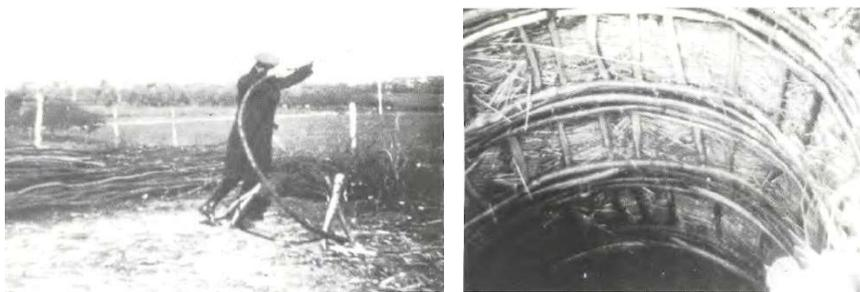
Les dimensions de ces galeries (les « *tchesses* ») obligeaient les « *derieux* » à travailler dans des positions peu confortables : la hauteur était d'environ 1,50 m et la largeur 1,20 m. La longueur pouvait atteindre 100 m. Elles étaient aérées par de simples tuyaux de zinc.
